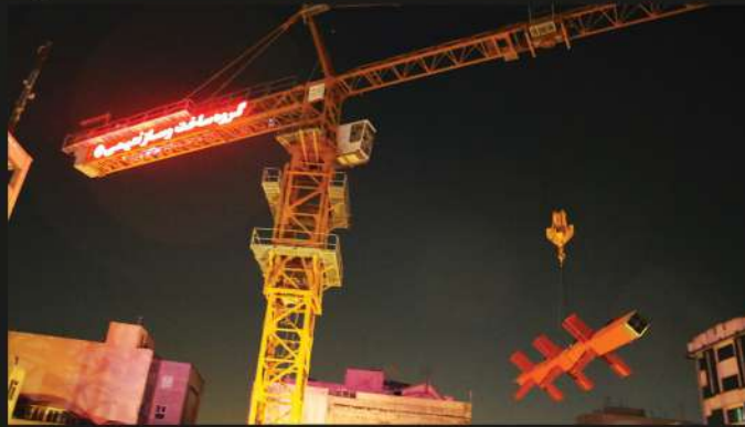
پروژه سهروردی اتصال پیچ و مهر WUF-W,BFP ۲۰۰۰ تن
