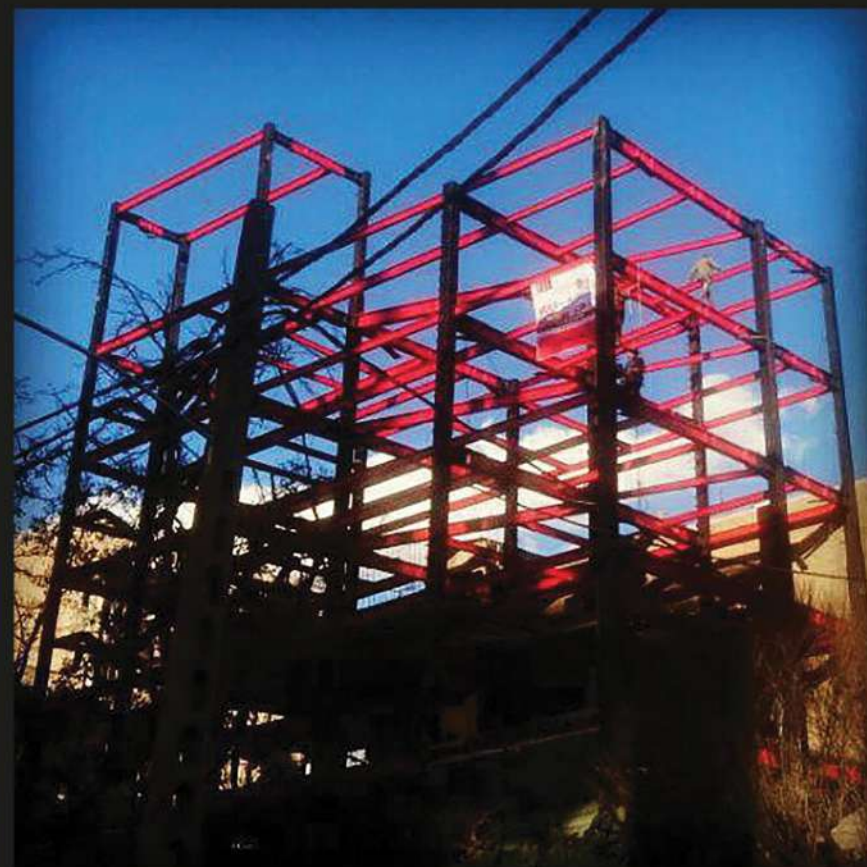
پروژہ اندرزگو (خیابان شریفی منش) اتصال پیچ و مهره WUF-W,BFP ۱۸۰ تن
