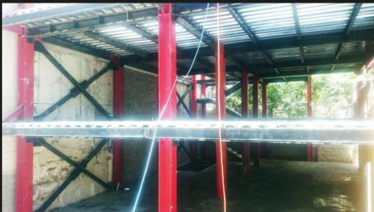
پروژہ کوروش (خیابان شریعتی) اتصال پیچ و مهره WUF-W,BFP ۲۷۰ تن
