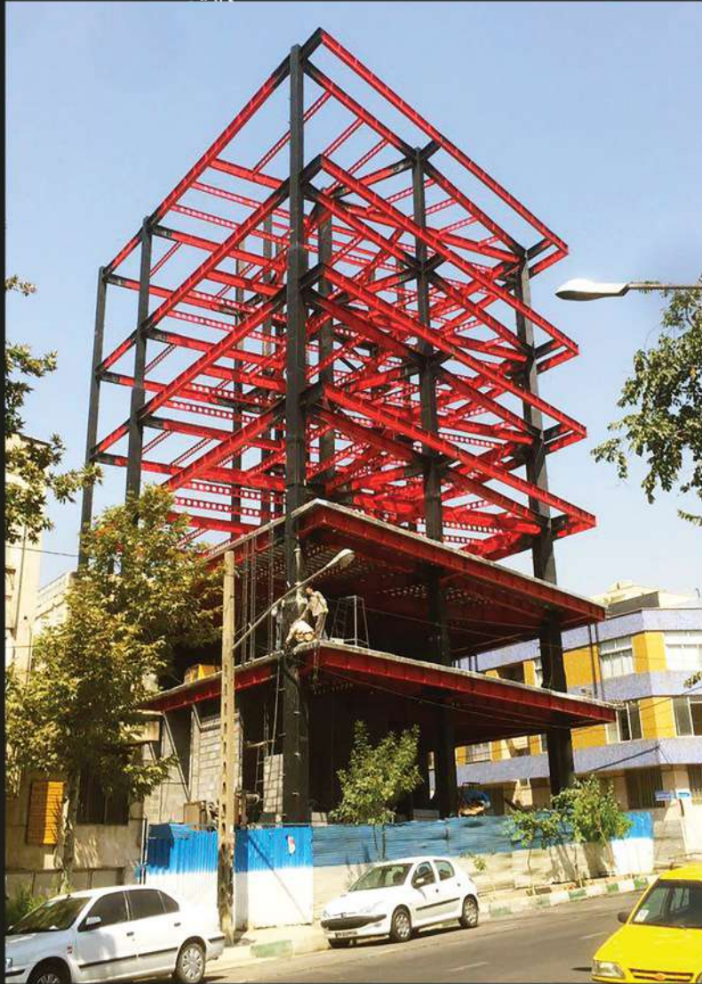
▶ پروژه هفت تیر (خیابان نوری اسفندیاری) اتصال پیچ و مهره WUF-W,BFP
