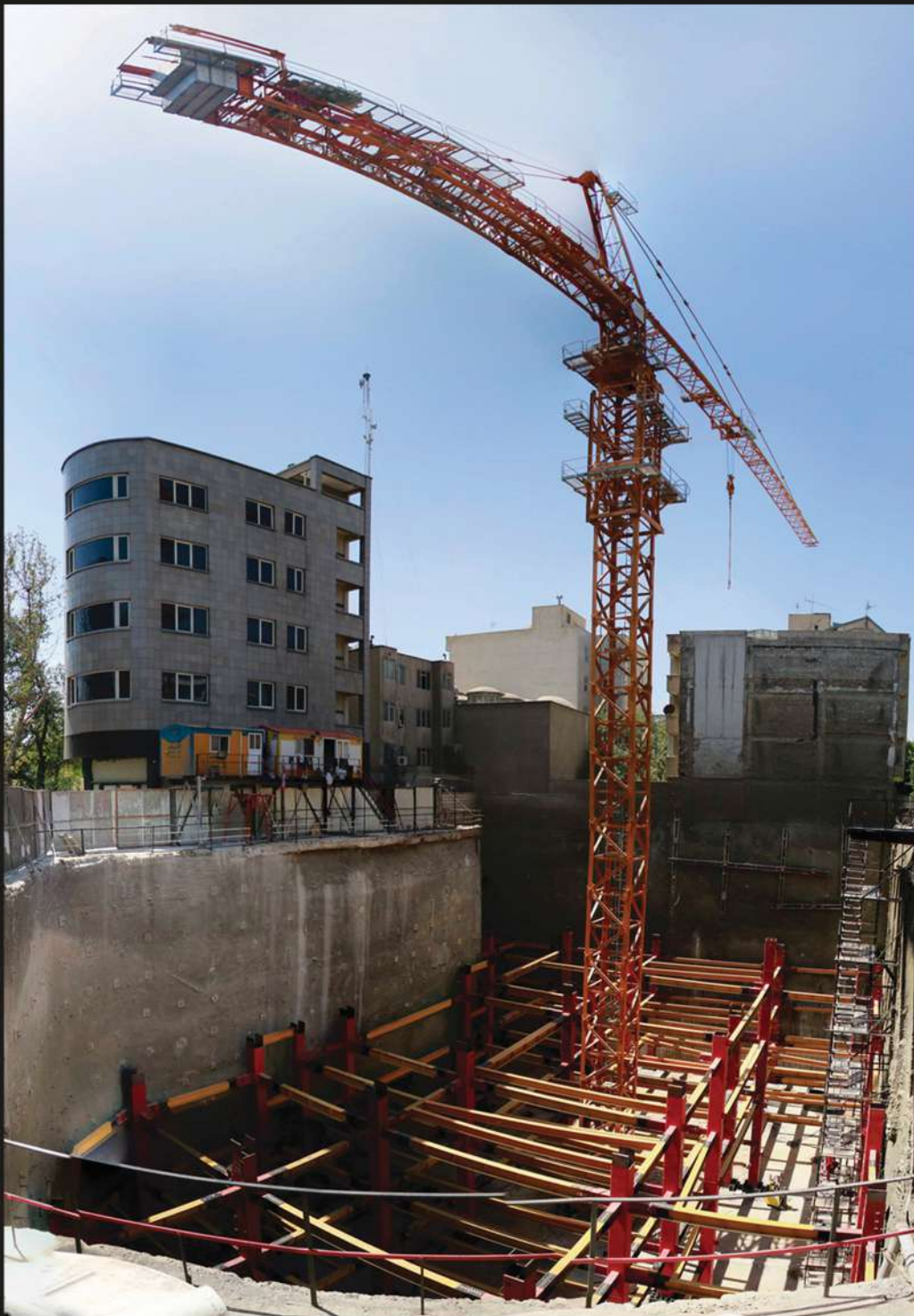
پروژه سهروردی اتصال پیچ و مهر WUF-W,BFP ۲۰۰۰ تن
