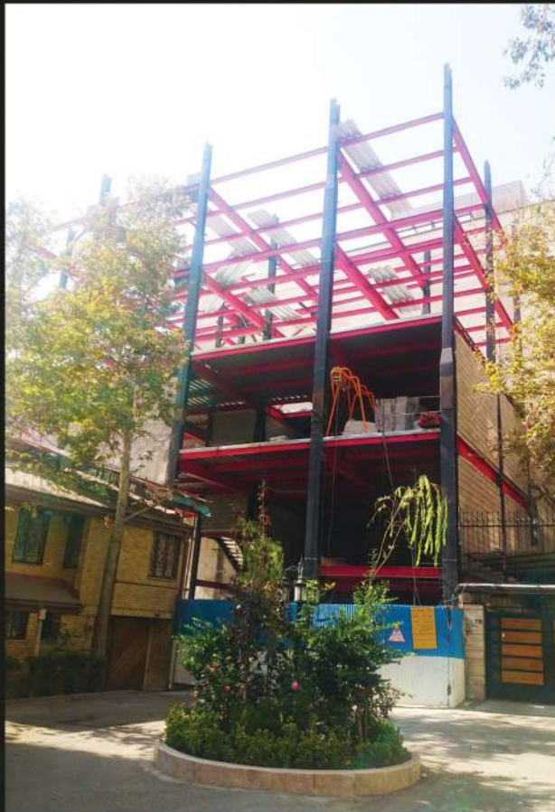
▶ پروژه فرمانیه (خیابان سعیدی) اتصال جوشی WUF ۲۷۰ تن
