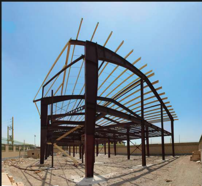
▲ پروژه سوله اریاک الکتریک اتصال پیچ و مهره ۱۰۰ تن
