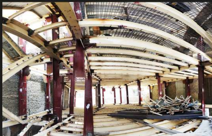
پروژه وزرا اتصال جوشی WFP ۱۰۰۰ تن
