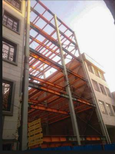
پروژه فاطمی اتصالات: WUF-W, BFP ۱۲۰ تن
