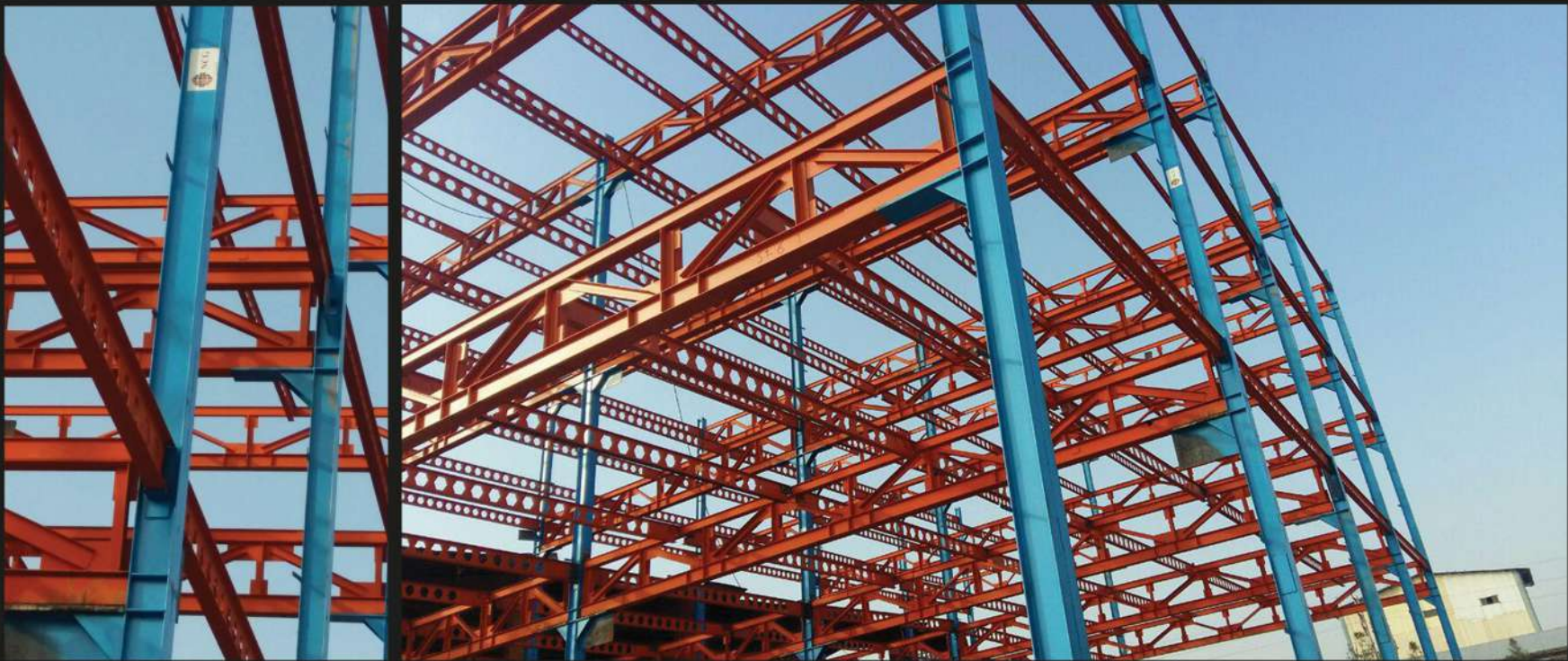
پروژه کارخانه کفش شوپا اتصال جوشی ۱۲۰ تن
