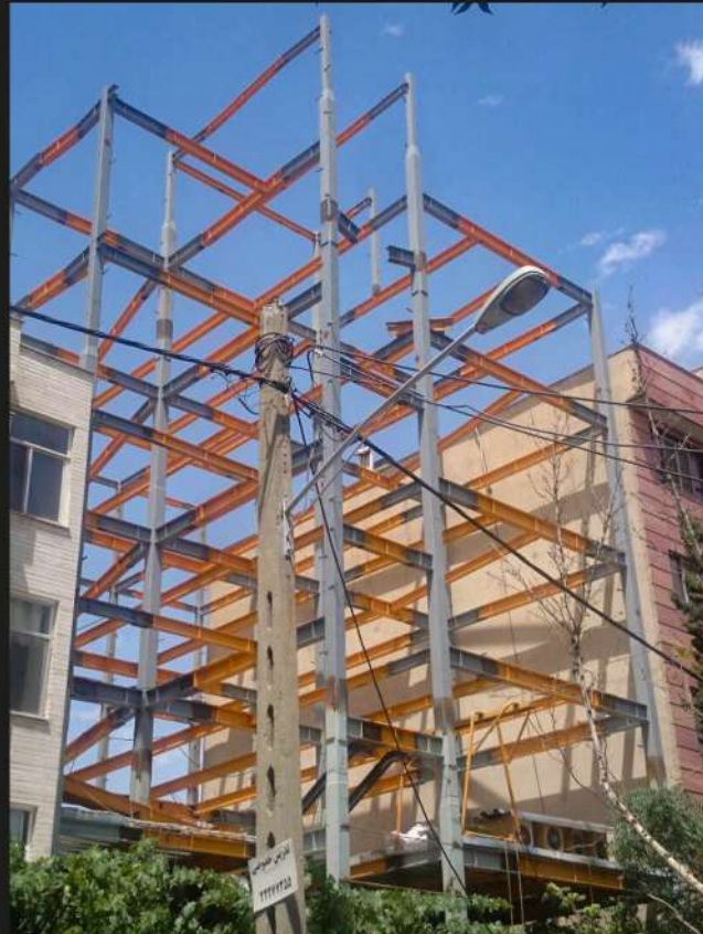
◀ پروژه جلفا اتصالات: WUF-W, BFP ۱۵۰ تن
