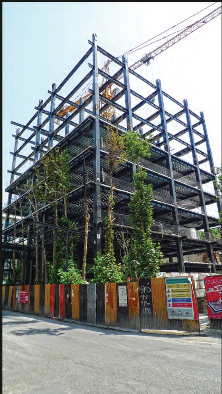
▶ پروژه تجاری-مسکونی الهیه ۱۸۰۰ تن اتصال جوشی
